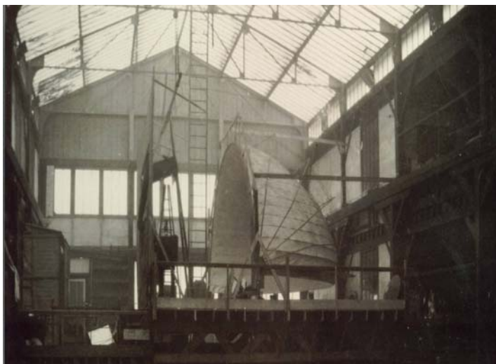
Mariano Fortuny, Prima prova d'illuminazione indiretta ad arco con cupola mobile a Parigi in rue Saint Charles , 20 gennaio 1902, Venezia, Museo Fortuny
